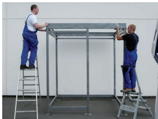
Enkel självmontering: Sats med enskilda delar med skruvförband (montering på plats).
