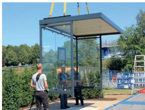
Montering i ett stycke: Installation av en helt svetsad och monterad vänthall av vårt logistik- och monteringssteam.
